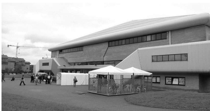
Il Palazzetto di San Lazzaro di Savena
